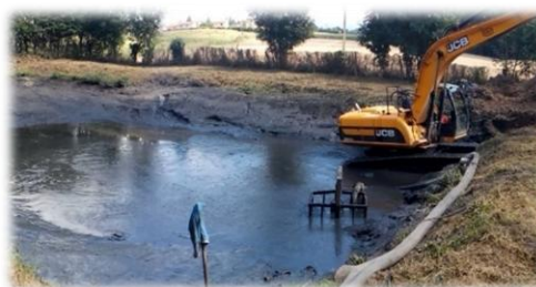
Curage d'un bassin de lagunage
