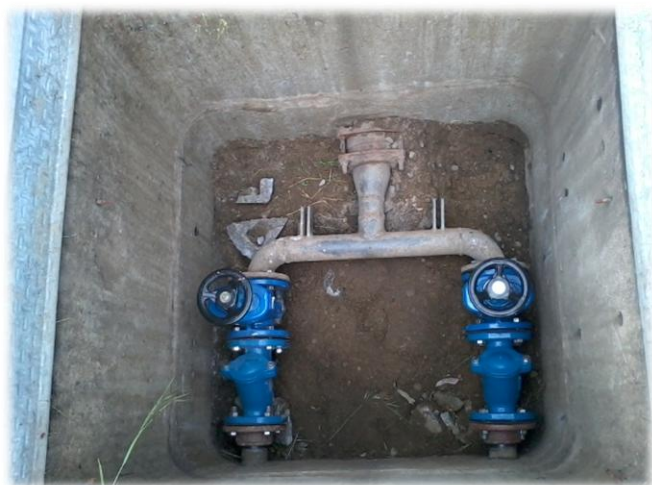
Renouvellement des clapets et vannes d'un poste de relèvement
