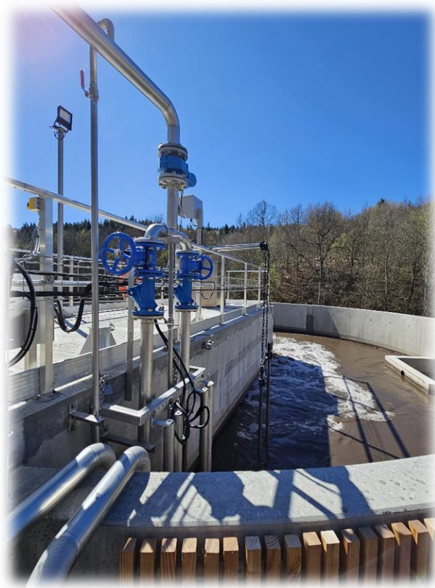
Station d'épuration par Boues activées de Luriecq Rivières
