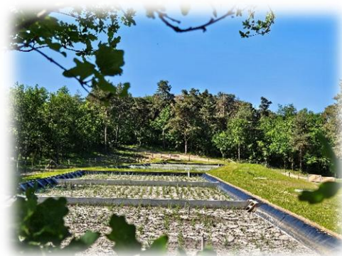
Chambles – Reconstruction de la station d'épuration du bourg
