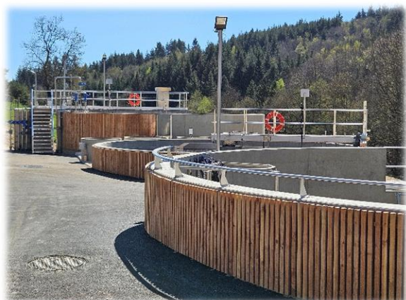
Luriecq – Reconstruction de la station d'épuration des rivières
