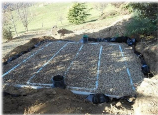
Exemple de réalisation
