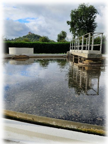
Station d'épuration de Saint-Romain-le-Puy
