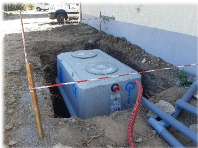
Exemple de réalisation
