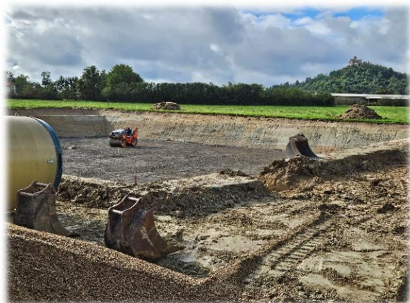
Saint-Romain-le-Puy – Création d'un bassin de stockage-restitution
