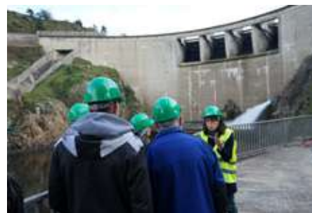
Barrage de Grangent
