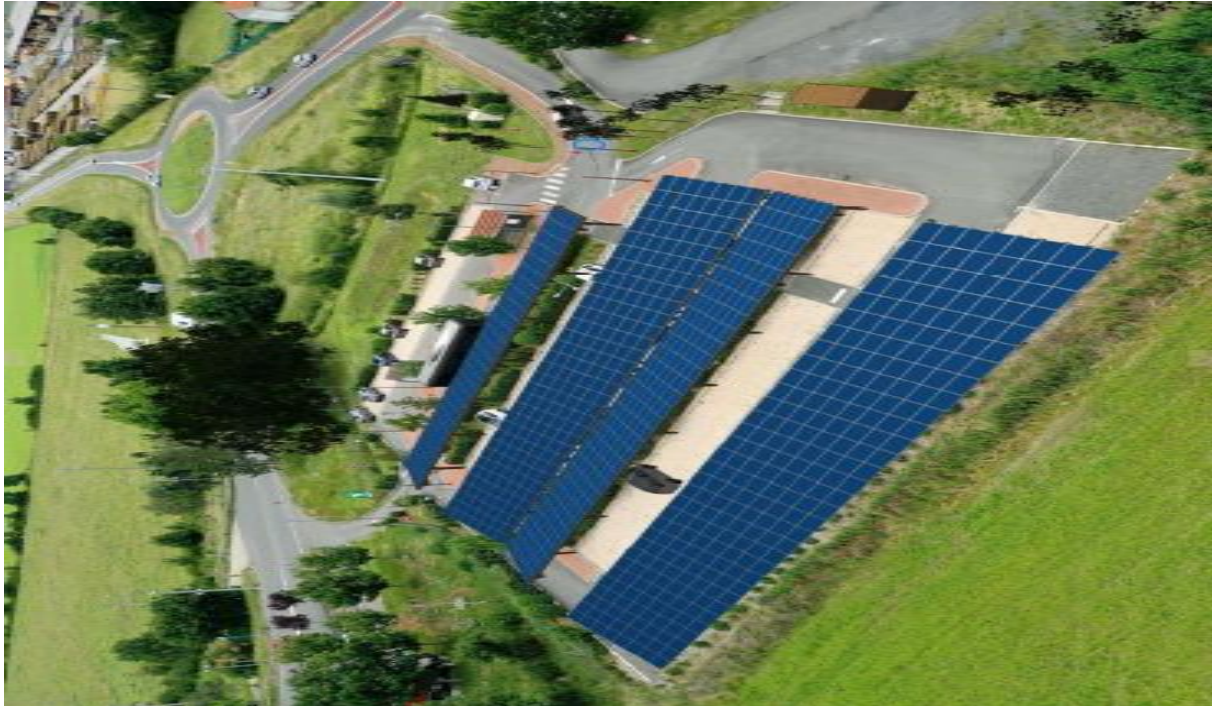
Vue aérienne des 4 ombrières sur aire de covoiturage de Chalain-le-Comtal
